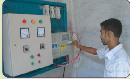
গভীর নলকূপে স্মার্ট কার্ড/জিপেইড মিটার স্থাপন কার্যক্রম
